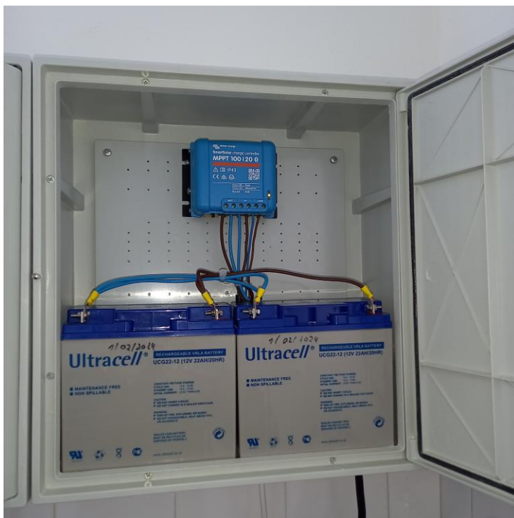
Sistema de telemetria e telegestão e painel fotovoltaico instalado no lugar do Bom Despacho, Almagreira
