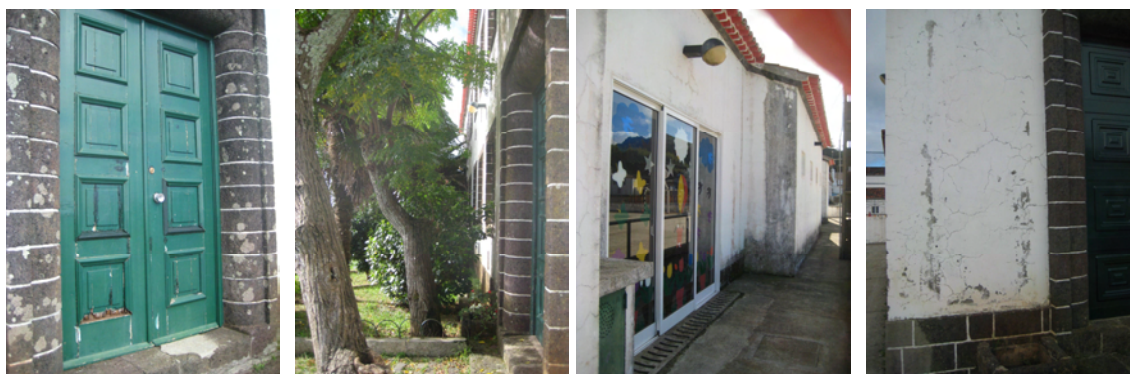
Figura 3.11_Estado de conservação dos edifícios escolares
