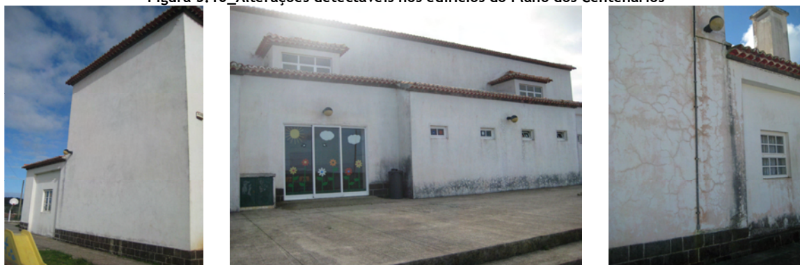
Figura 3.10 _Alterações detectáveis nos edifícios do Plano dos Centenários
