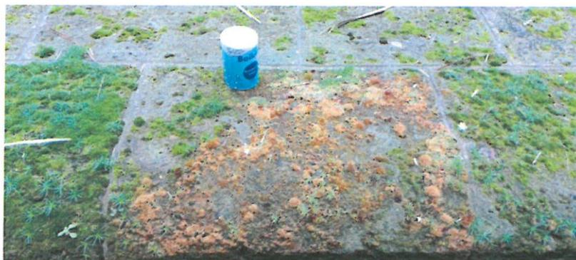
**Figura 6** – Efeito da aplicação de Bicarbonato de sódio em zona com líquenes, esbranquiçados e secos, verifica-se a diferença na lage que apresenta a tonalidade mais escura
